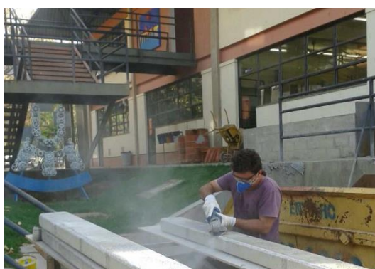
Figura 2 – Processo de lixamento para reforço por encamisamento
