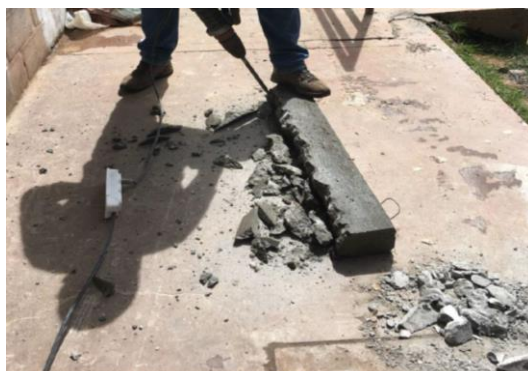
Figura 1 – Processo de escarificação para reforço por encamisamento
